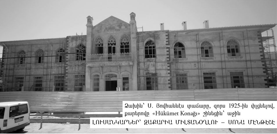
Չախիս՝ Ս. Յովհաննէս փոճարը, գործ 1925-ին փոցնելով, քարերով «Hükümet Konagi» շինեցին՝ աջին ԼՈՒՍՆԱԿԱՐԵՐ՝ ԶԱԲԱՐԿՈ ՄԻԼՏԱՏՈՂԼՈՒ – ՍՈՐԱ ՄԵՆԹԵՆԷ
